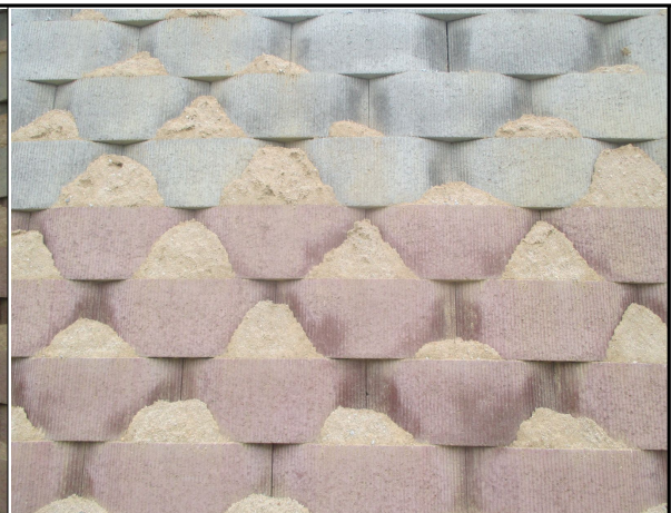
원주 R-B STA.0+599~0+968 옹벽 시공 상태
