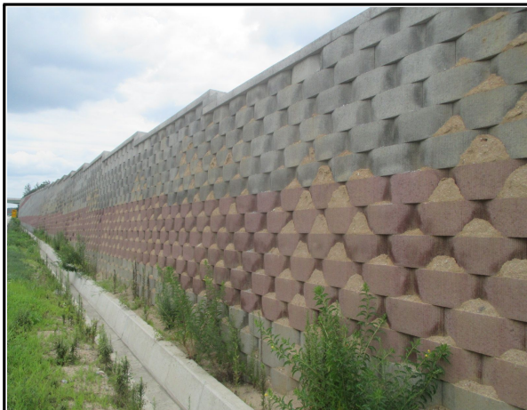
원주 R-B STA.0+599~0+968 옹벽 시공 전경
