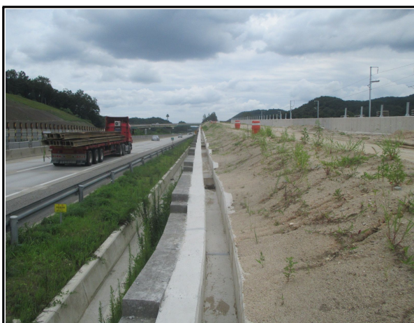
원주 R-B STA.0+599~0+968 옹벽 상단 시공 전경
