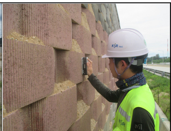
원주 R-B STA.0+599~0+968 옹벽 기울기 측정
