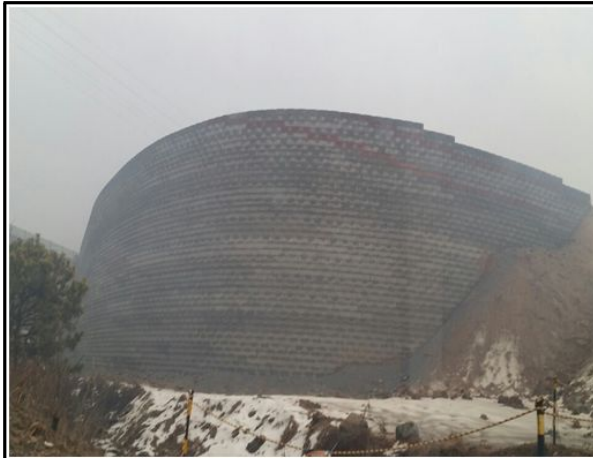
원주 R-B STA.0+599~0+968 옹벽 시공 상태
