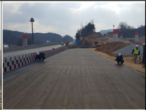
원주 R-B STA.0+599~0+968 그리드 길이 측정
